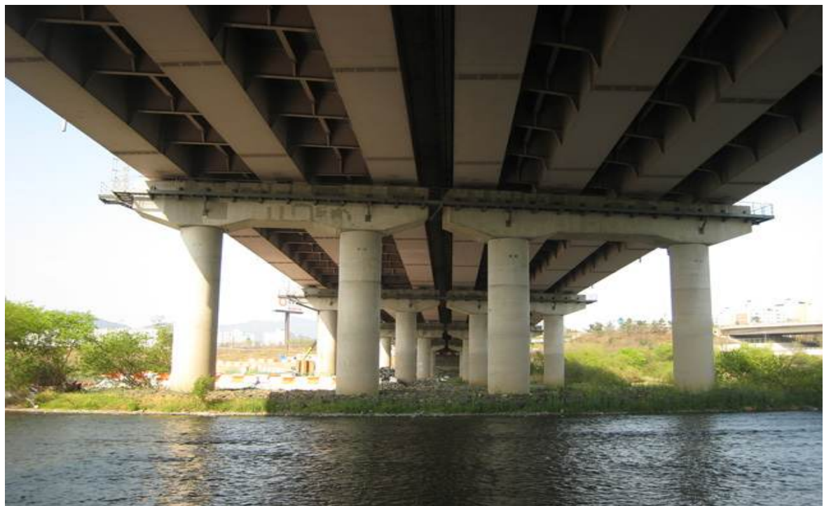
하부구조 전경 - 교각(P6)
