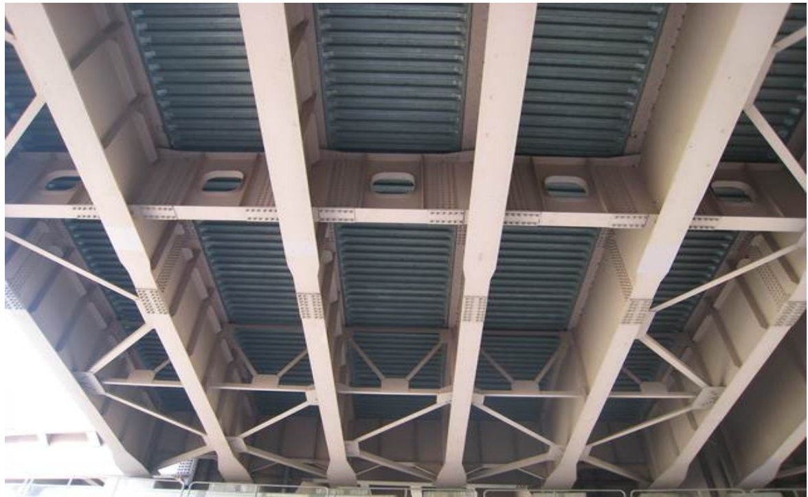
상부구조 전경 - 외부(SPG-S1)
