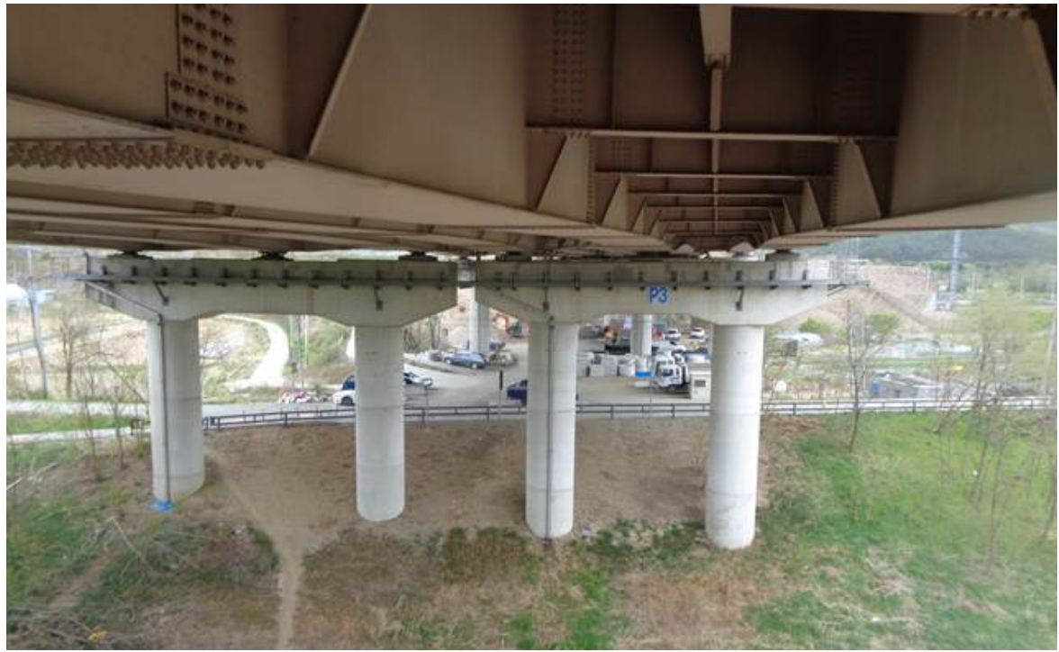
하부구조 전경 - 교각(P3)
