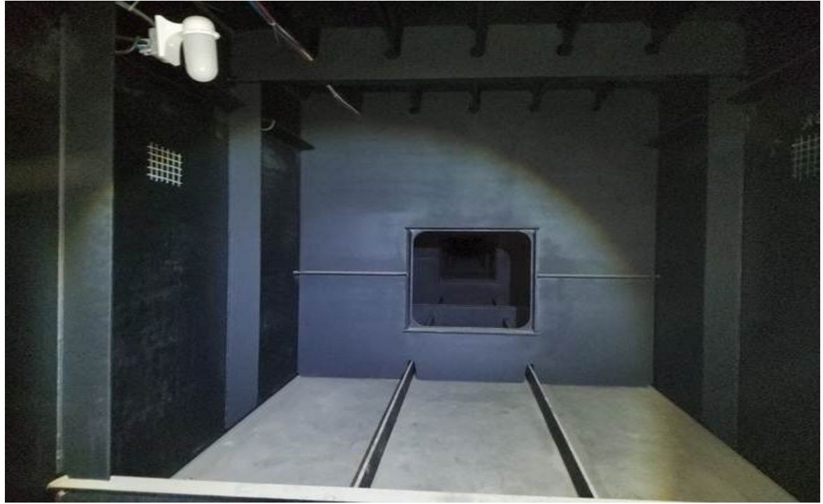
상부구조 전경 - 내부
