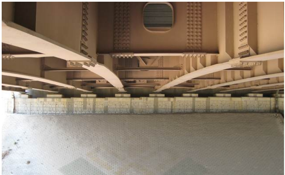
하부구조 전경 - 교대
